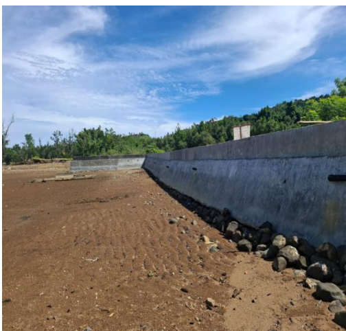
Penanggulangan Pantai Desa Harmoni Kec. Palele Barat Kab.Buol
