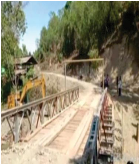
Penanganan Darurat Bencana dan Keperluan Mendesak Pembongkaran,Pemasangan dan AngkutanJembatan Darurat Bailey Kawasan Desa Bongkakoi kecamatan Ulubongka Kabupaten Tojo una-una.
