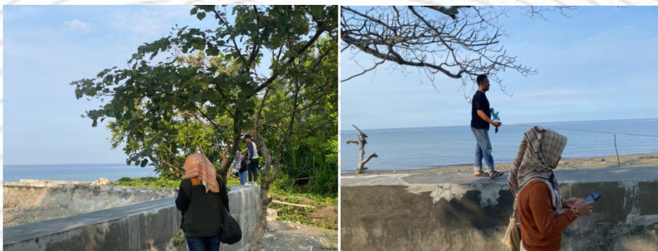
Gambar 3.4 Pembangunan talud di kab.Morowali
